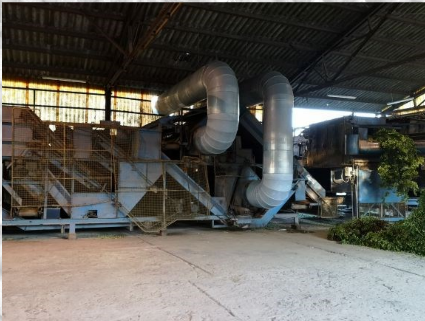
Modernizacja stanowiska zbioru chmielu – montaż systemu odpylania.
